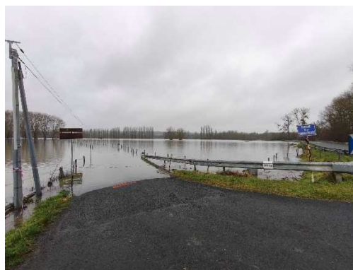
Le Loing à Episy au pic de crue – 21/02/26
