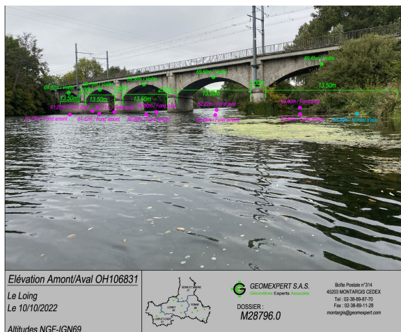
Photo et levé d'ouvrage du pont SNCF à l'aval de Souppes-sur-Loing (source : Geomexpert, 2023)
