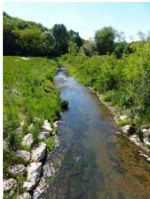
Figure 70 : Photo de berges adoucie (SIEABA)
