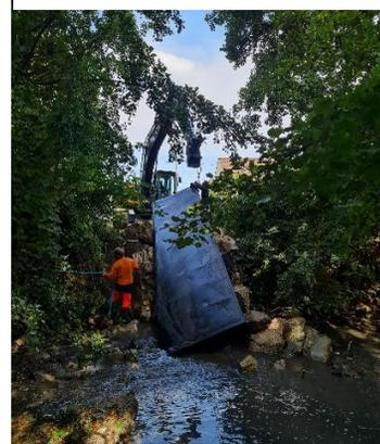
Figure 47: Démantèlement du barrage de Montalibert (Châlette-sur-Loing) pendant sa suppression - 10/08/2023
