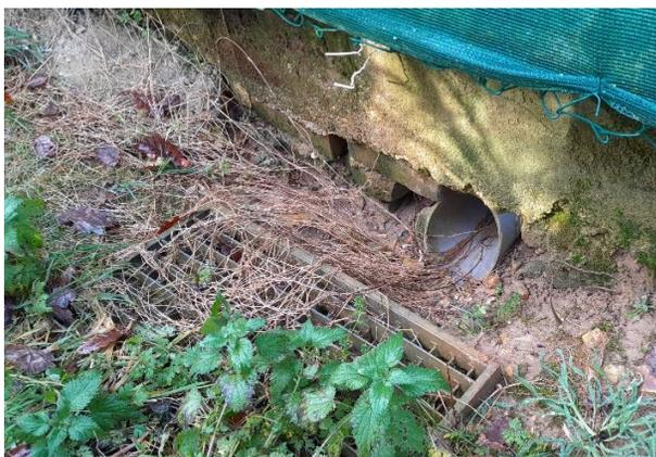
Figure 97: Canalisation permettant à l'eau de franchir le mur de la propriété. A l'aval immédiat, elle est plus ou moins connectée à une seconde canalisation, souterraine cette fois, permettant de passer sous la propriété impactée
