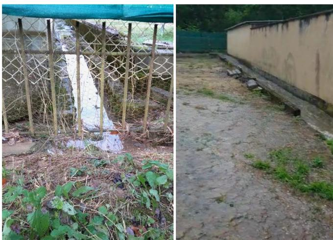
Figure 98: Fossé béton cadastré permettant le ressuyage partiel des eaux de ruissellement
