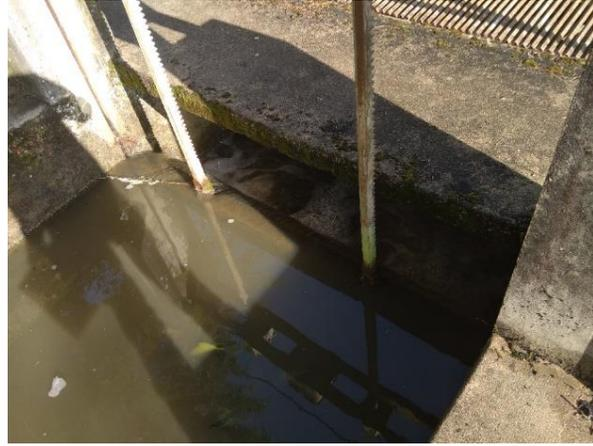
Figure 73: Déversoir (à gauche) et vanne (à droite)
