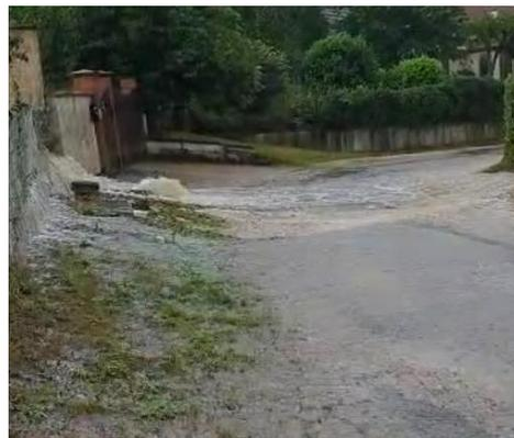
Figure 99: Avaloir situé à l'aval du fossé béton (a) ; Ruissellement de surface suite à la mise en charge du fossé béton (b)
