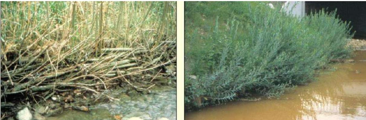
Figure 73 : Exemple de tressage en saules qui sera réalisé sur la première partie du linéaire
