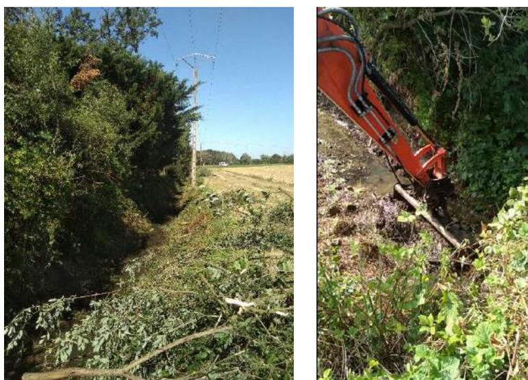
Figure 59 : Entretien de la végétation (à gauche) et suppression des sédiments pollués (à droite) - CLERY
