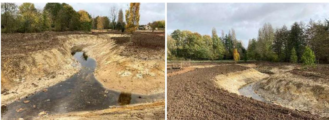
Figure 51 : Reméandrage du Limetin - BEZONDE
