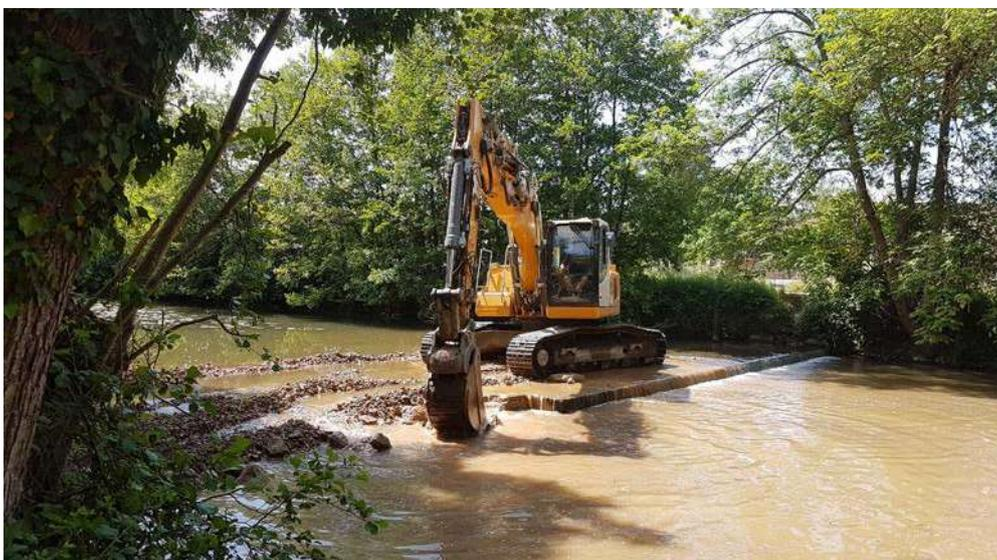
Figure 21 : Suppression du seuil du camping de Montbouy – LOING AMONT
