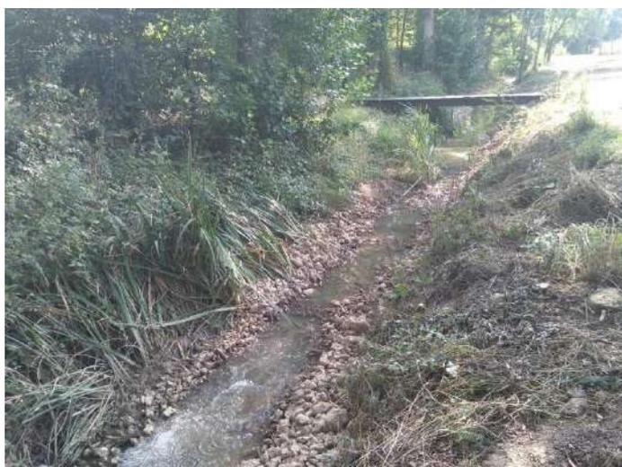
Figure 61 : Recharge granulométrique (silex) sur l'ensemble du tronçon - CLERY
