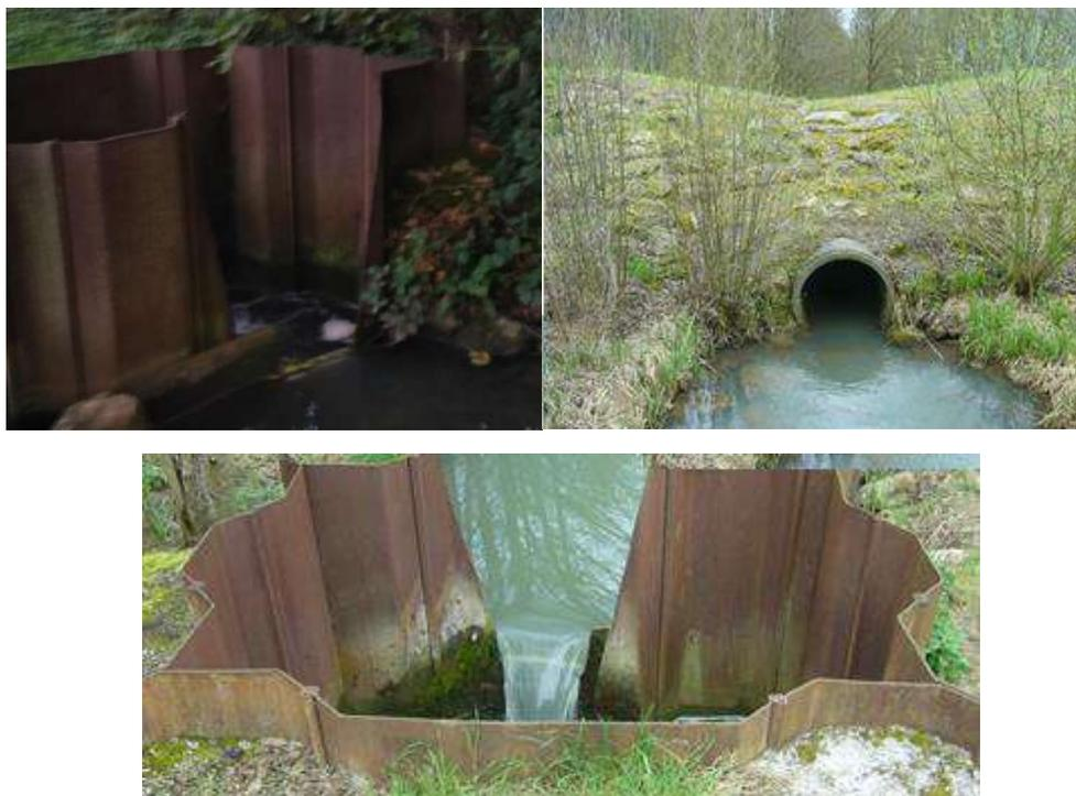
Figure 72 : Bassin d'orage à Dollot, palplanche, buse et digue en terre - Dollot (89) - ORVANNE
