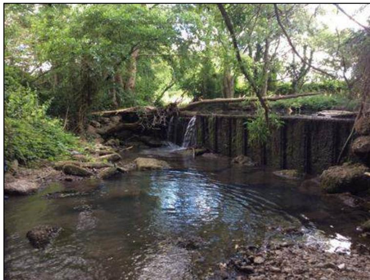
Figure 67 - Déversoir OH1 du moulin Brandard faisant totalement obstacle au transit sédimentaire et piscicole - BETZ
