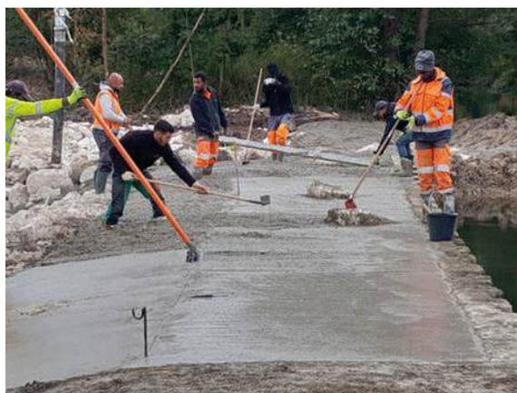
Figure 21 - Action emblématique n°3 – Travaux de consolidation du déversoir
