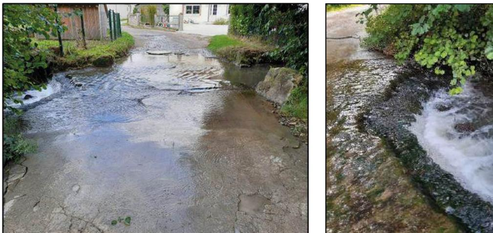
Figure 65 - Photographie 3 : Vue sur le passage à gué (à gauche) et présence d'une chute en aval faisant obstacle à la continuité écologique (à droite) - CLERY
