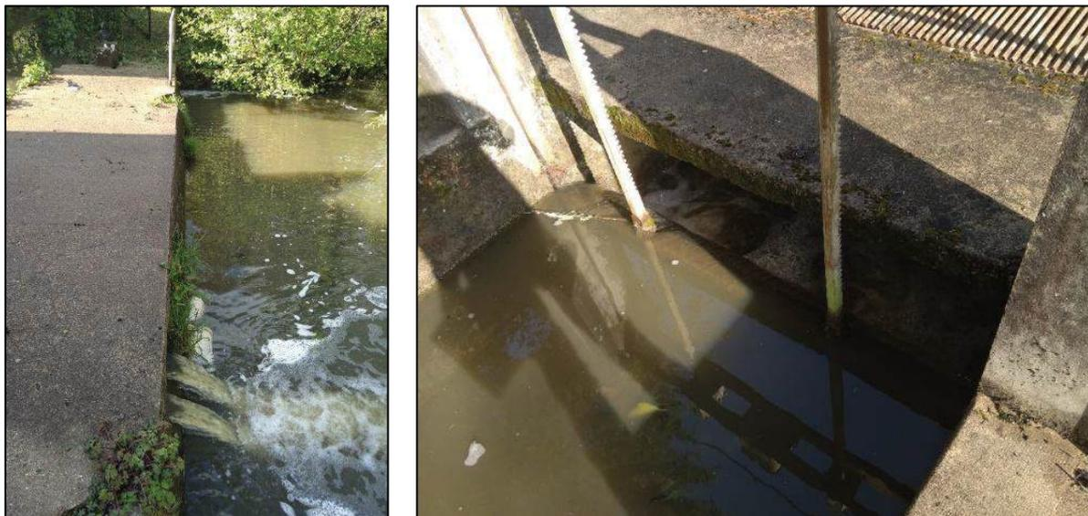
Figure 70 - Déversoir (à gauche) et vanne (à droite) - BETZ
