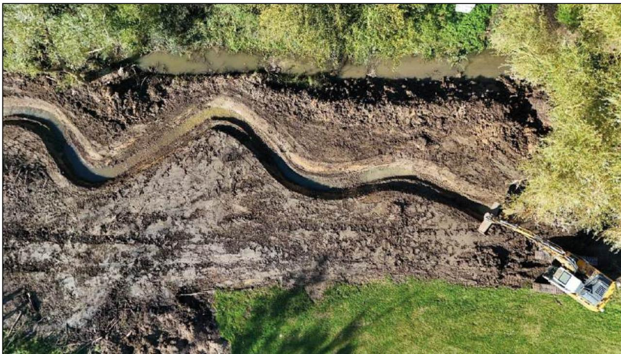
Figure 73 - Reméandrage du Betz au droit du stade de Domats. On distingue le Betz sinueux nouvellement créé, et l'ancien Betz, de forme rectiligne - BETZ
