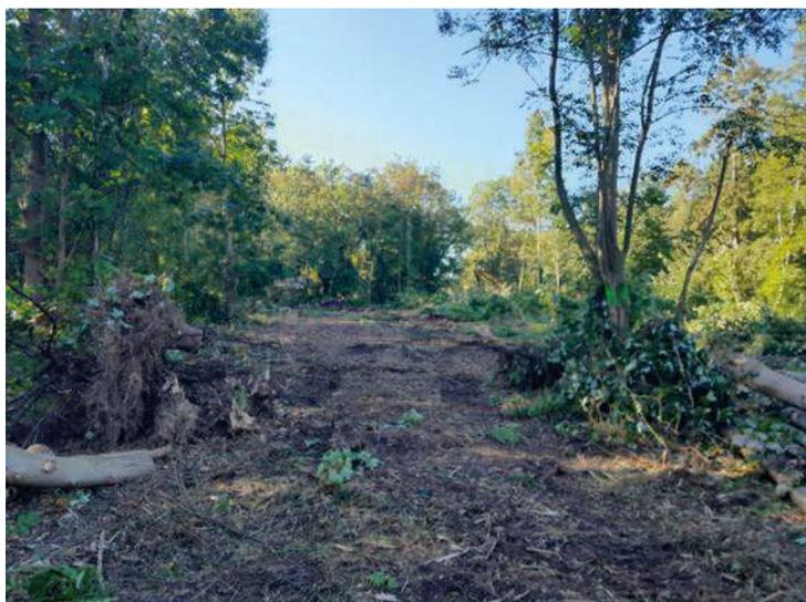
Figure 18 - Action emblématique n°3 - Défrichage de la zone de travaux
