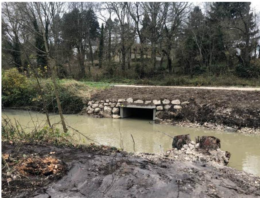
Figure 42 - Installation du dalot entre le canal de Briare et le Loing – LOING AMONT
