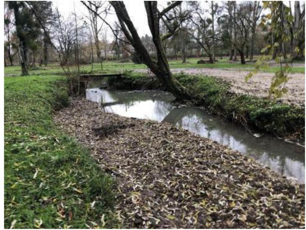
Figure 43 - Avant - après travaux, suppression des seuils avec mise en place de banquette alternée - LOING AMONT
