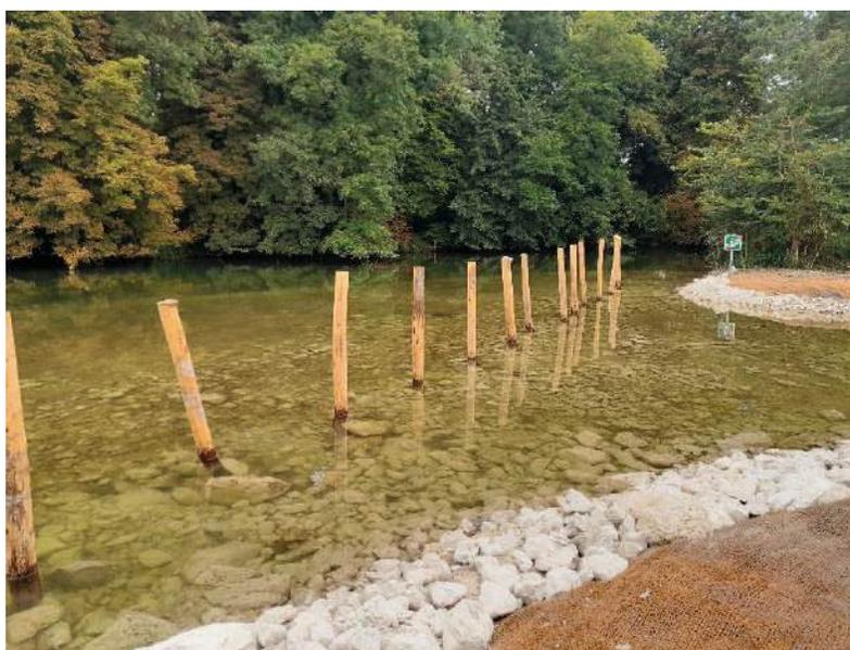
Figure 22 - Action emblématique n°3 - Mise en place de pare-embâcles à l'entrée du bras de contournement
