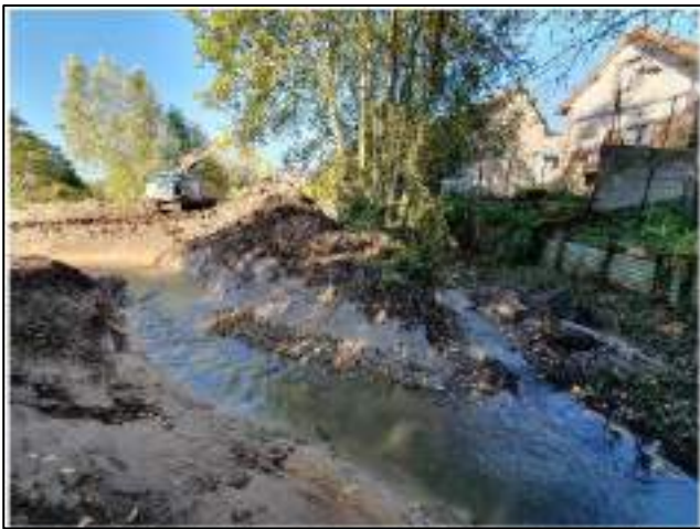
Figure 76 - Mise en eau du bras du Betz nouvellement créé au droit du stade (à gauche) et mise en place de banquettes minérales dans le Betz au droit des bassins de lagunage (à droite) - BETZ
