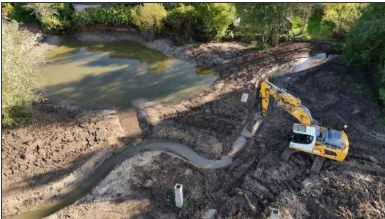
Figure 73 - Reméandrage du Betz au droit du stade de Domats - BETZ
