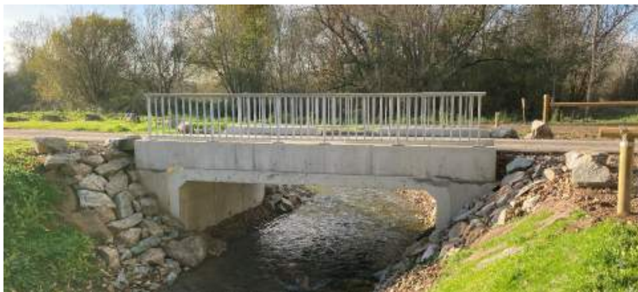
Figure 93 - Photographie d'un exemple de pont de type dalot - LUNAIN
