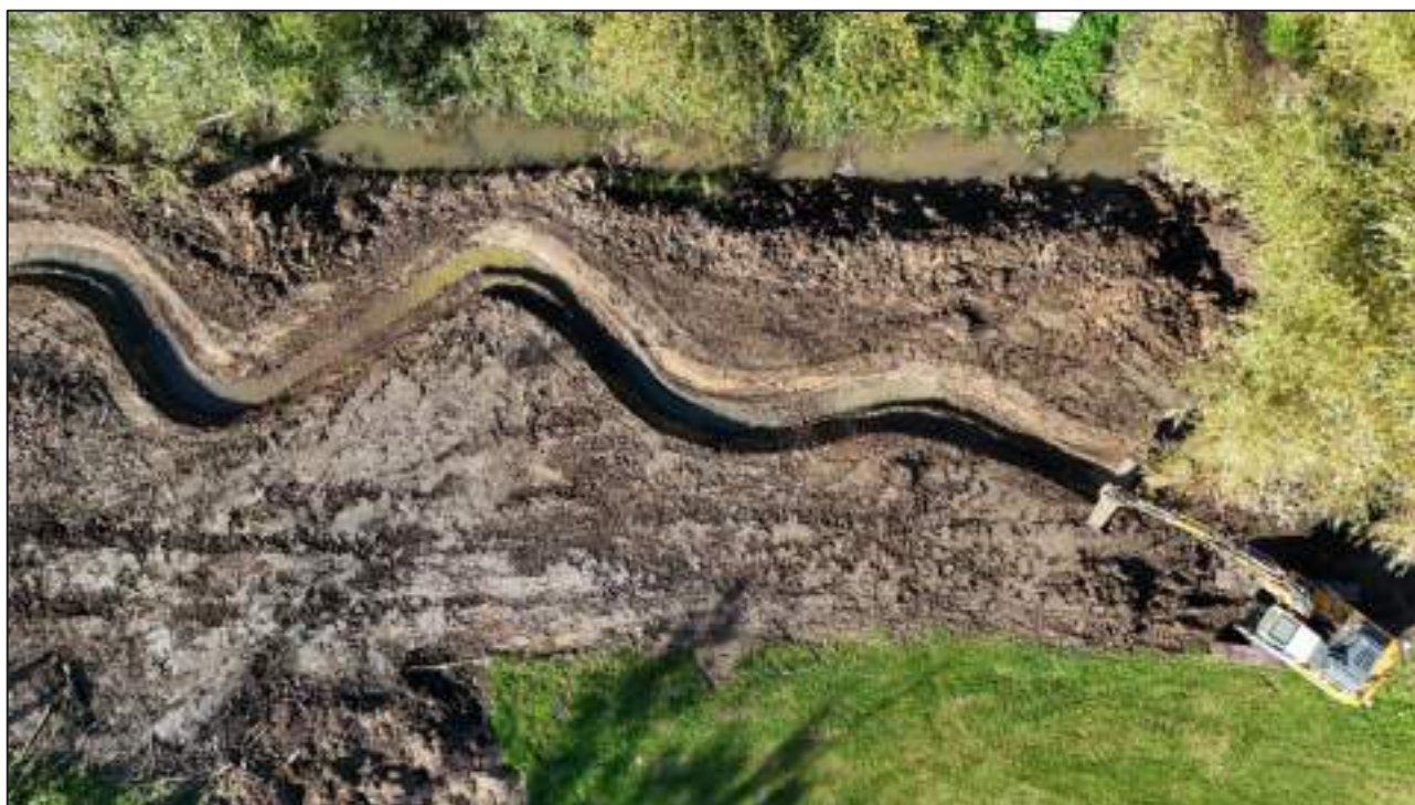
Figure 74 - Reméandrage du Betz au droit du stade de Domats. On distingue le Betz sinueux nouvellement créé, et l'ancien Betz, de forme rectiligne - BETZ
