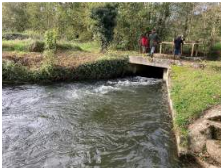
Figure 61 - Vanne du Moulin Neuf à Cepoy - LOING MEDIAN
