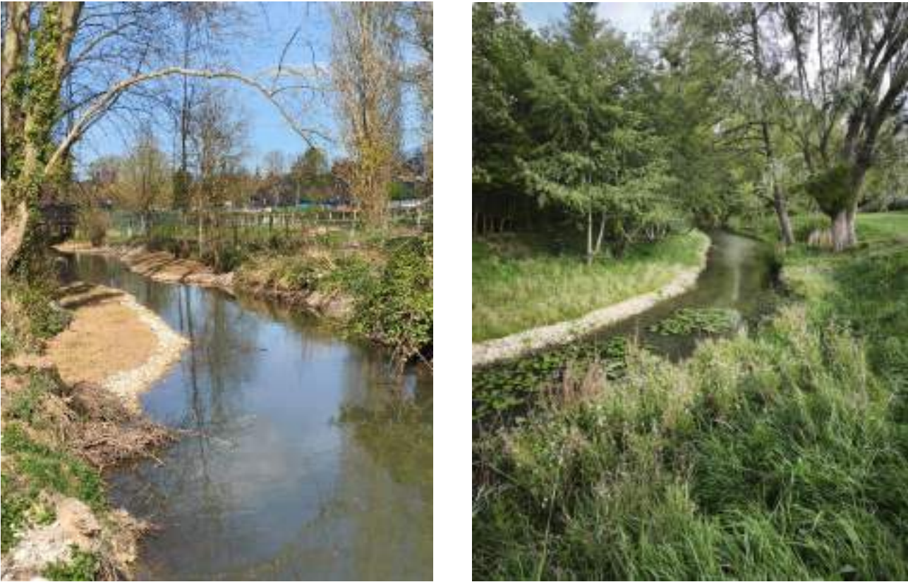
Figure 40 - Banquettes alternées en amont du Moulin de la Fosse - LOING AMONT
