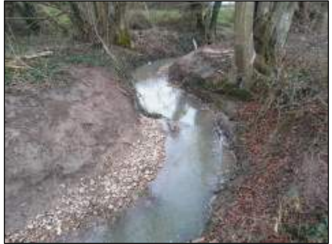
Figure 76 - Mise en eau du bras du Betz nouvellement créé au droit du stade (à gauche) et mise en place de banquettes minérales dans le Betz au droit des bassins de lagunage (à droite) - BETZ
