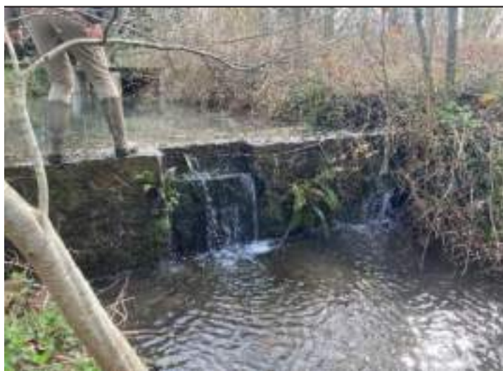
Figure 69 - Premier ouvrage au droit du Ru de Pense-Folie, à quelques mètres de la confluence avec la Cléry - CLÉRY
