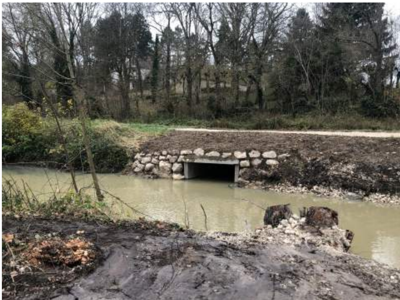
Figure 36 - Installation du dalot entre le canal de Briare et le Loing - LOING AMONT
