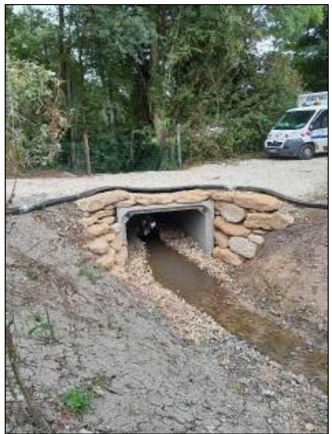
Figure 77 - Tronçon amont restauré (à gauche) et remplacement d'un passage busé par un dalot (à droite) - BETZ
