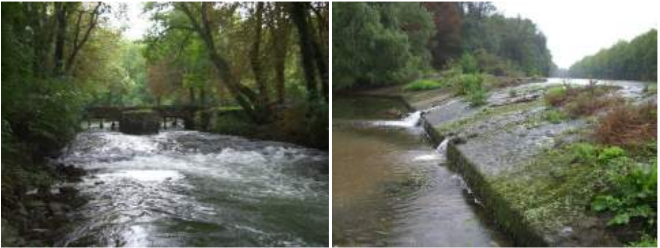
Figure 65 - Ouvrage de décharge du Moulin (à gauche) et déversoir latéral (à droite) - LOING MEDIAN
