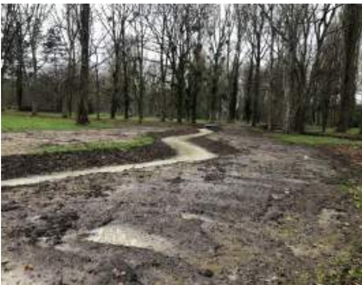
Figure 38 - Création du bras de contournement en amont du Moulin de la Fosse (à droite après réalisation, à gauche 1 an après travaux) - LOING AMONT
