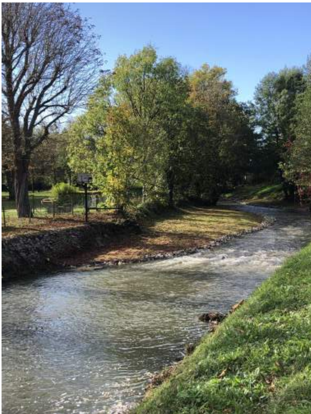
Figure 35 - Seuil de la Lancière après travaux - LOING AMONT
