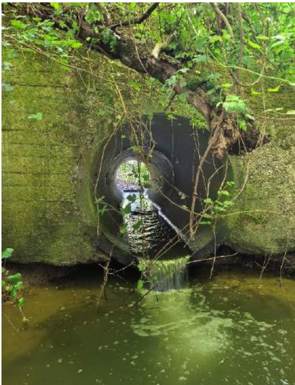
Figure 91 - Photographie de la chute aval du pont à Courtoin - LUNAIN
