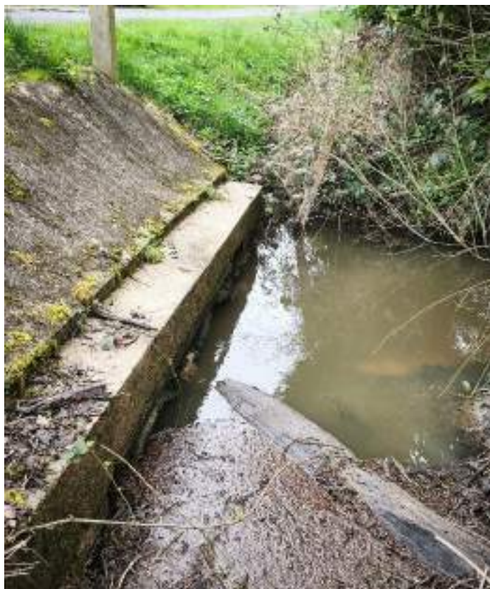
Figure 57 - Photographie de l'ouvrage de la Motte Bucy à Sury-aux-Bois - BEZONDE
