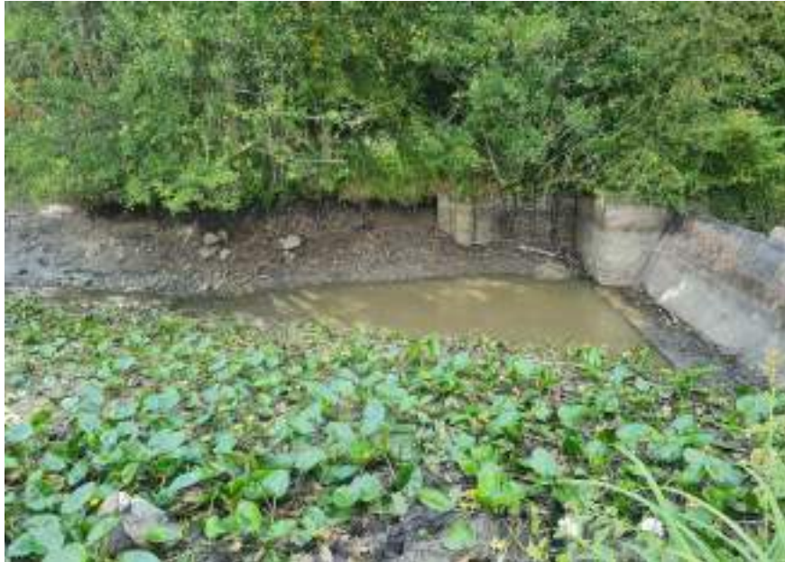
Figure 52 Le barrage de Platteville sur le Solin à Villemendeur SOLIN
