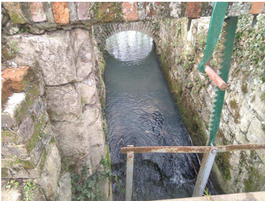
Ancien bras usiné CHA1 (présence d'une roue dans le passé)
