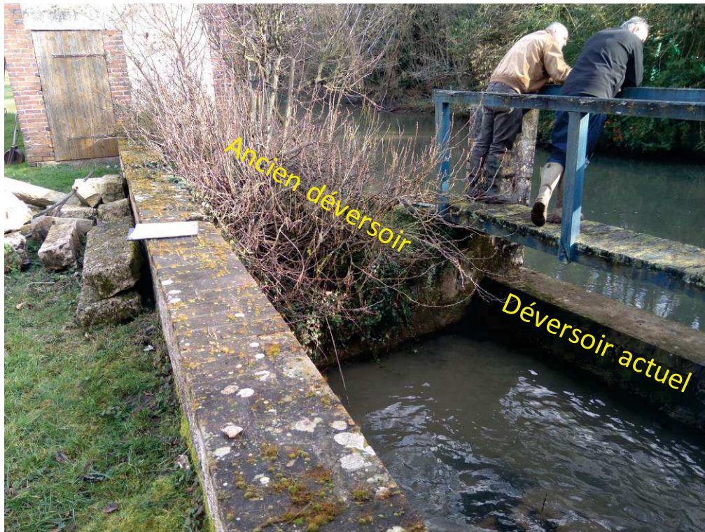
Ouvrage FOR2 - vue sur le déversoir actuel (à droite) et l'ancien déversoir (à gauche)
