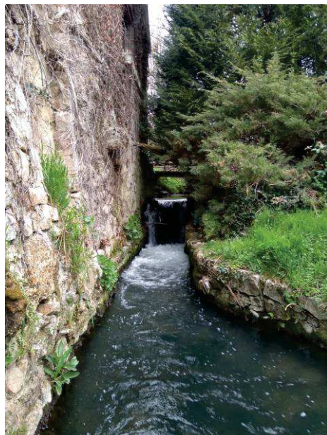
Ouvrage AND 1 (vannes AND2 fermées)
