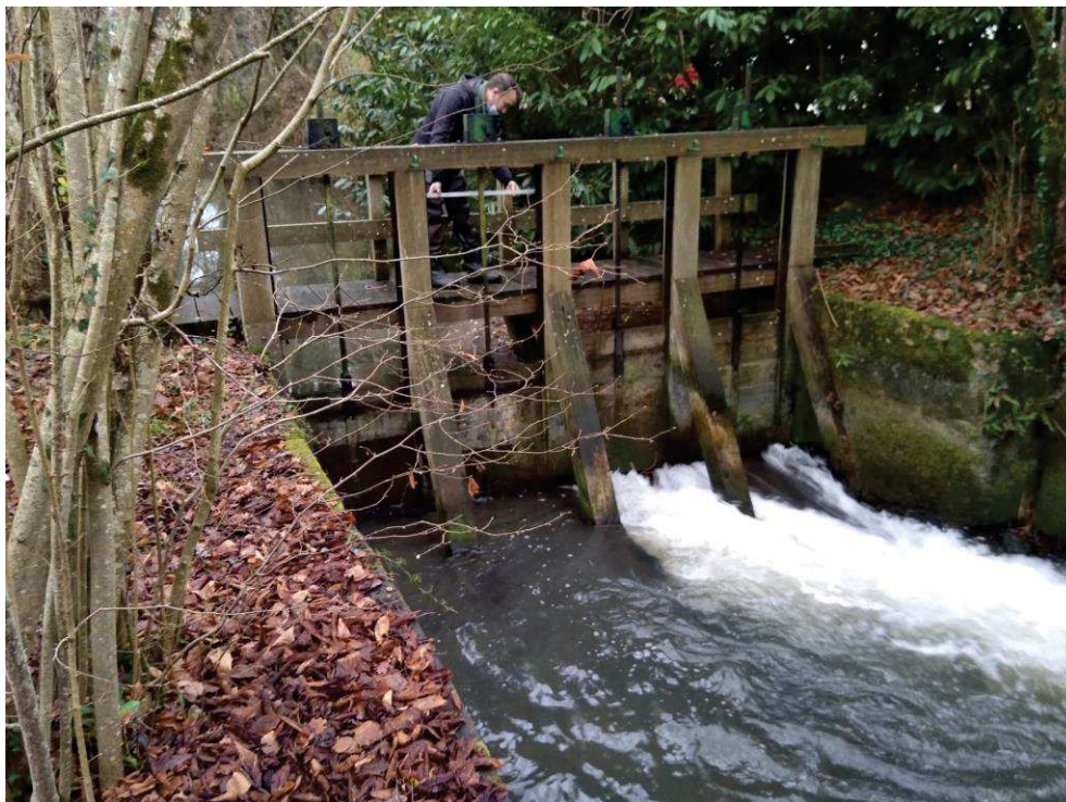
Vue sur l'ouvrage TAN1 - 4 vannes manoeuvrables
