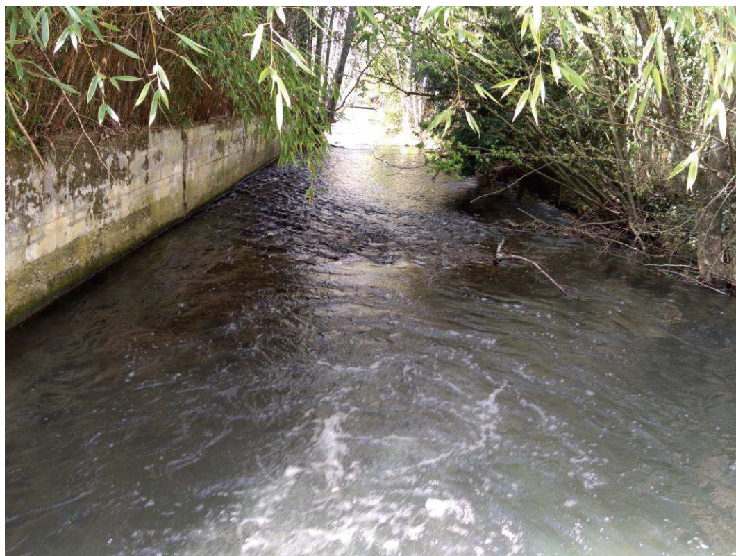
Aval du bras B2
