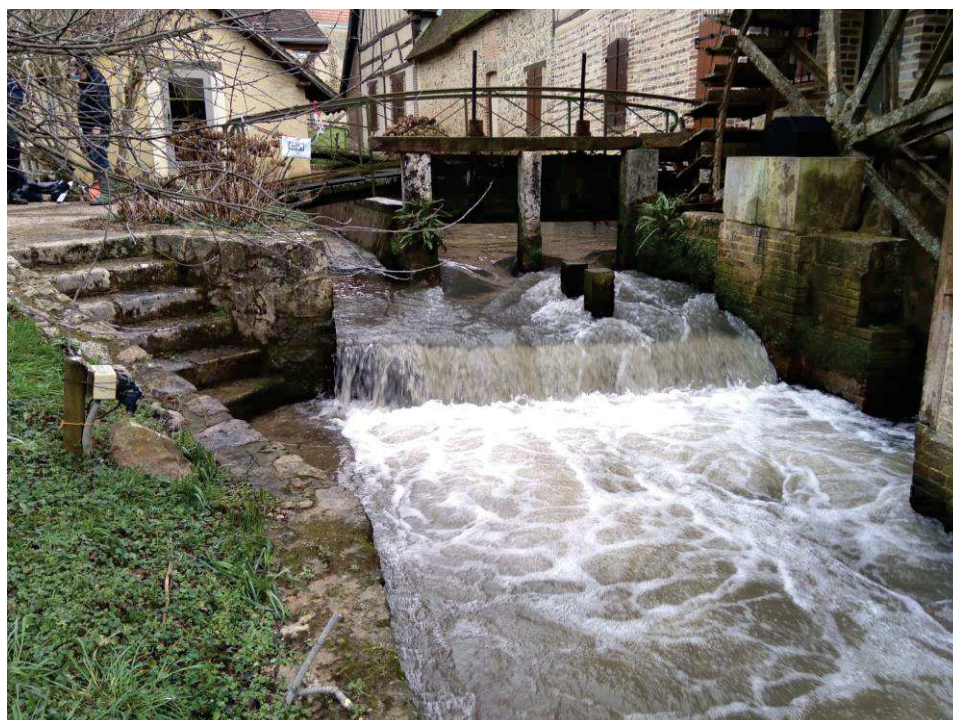
Vue sur les vannes du moulin (position ouverte)
