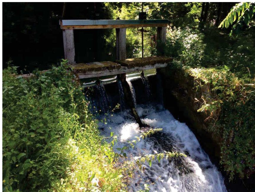
Ouvrage PLA1 au moment de l'ouverture des vannes
