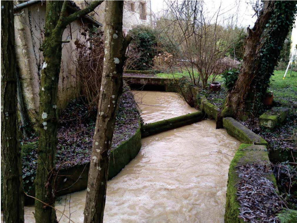
Bras de décharge
