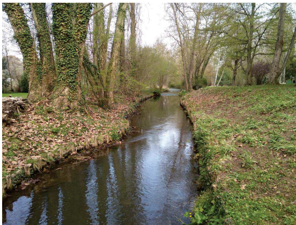
Vue sur l'aval de l'ouvrage ELO1
