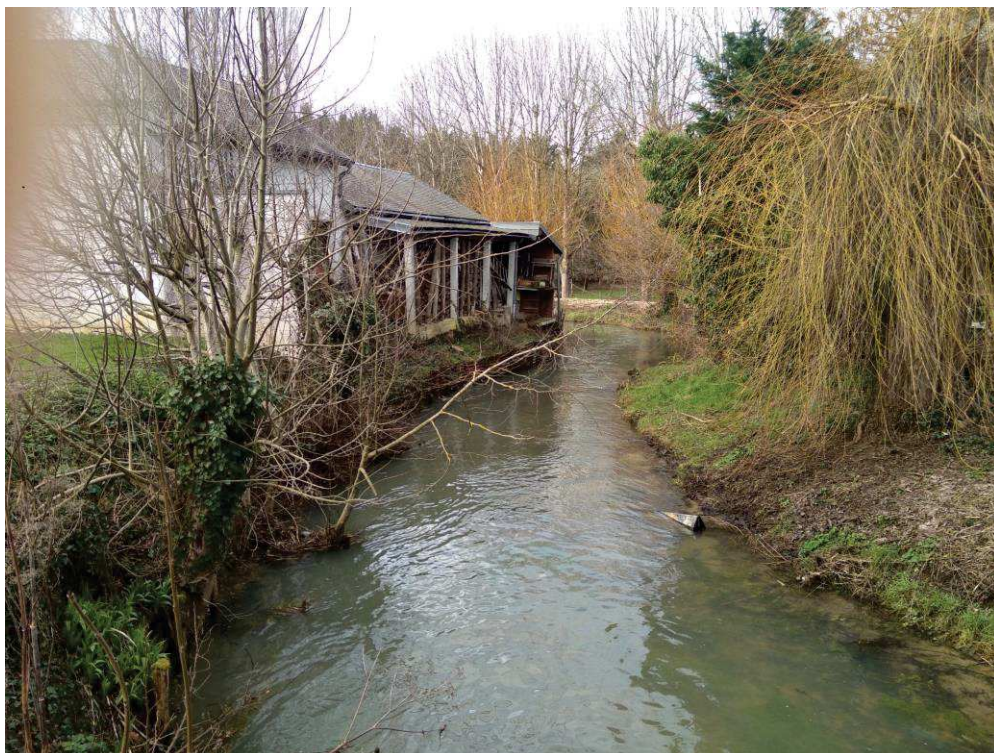
Vue sur l'aval du moulin
