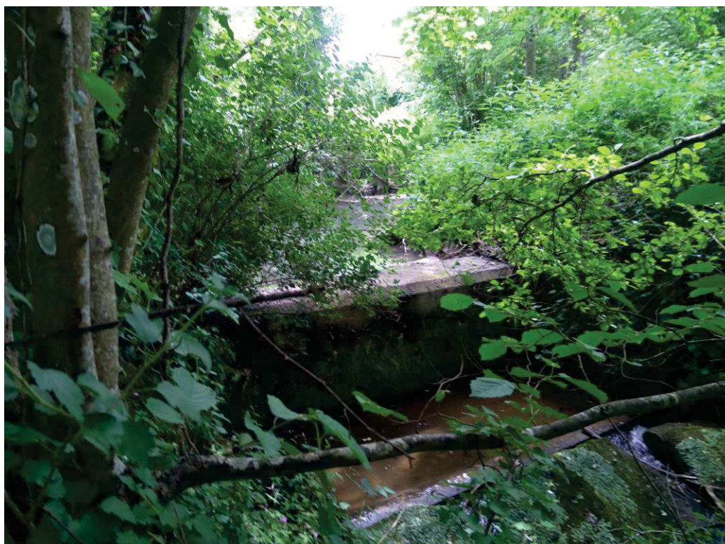
Seuil O1 - à sec à vanne ouverte et fermée
