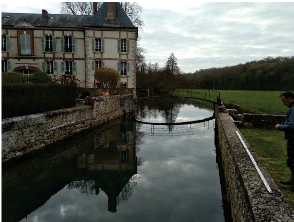
Vue sur le bief en amont de l'ouvrage SEL1
