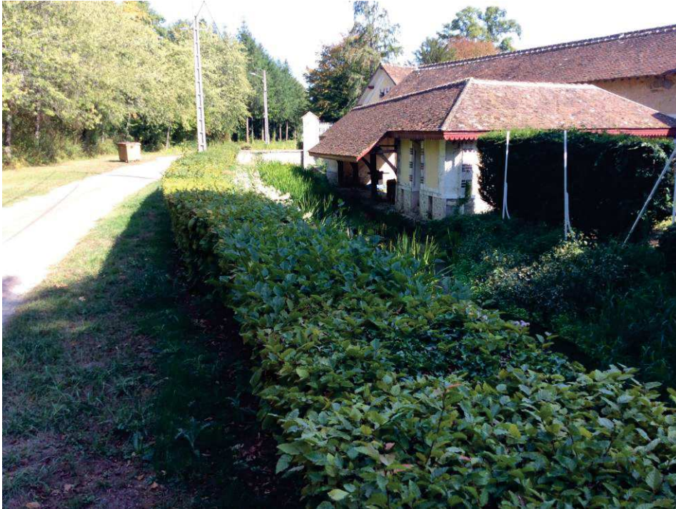
Lavoir au droit de la fausse rivière
