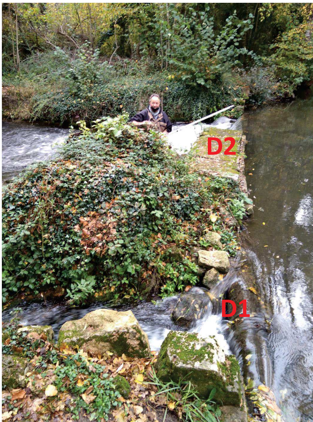
Vue sur l'ouvrage GRI2 avec le déversoir D2 et le bras de décharge D1
