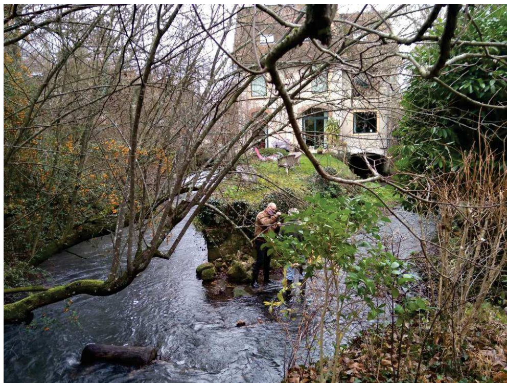
Vue sur la difffluence des deux bras du bief - aval de TAN1
