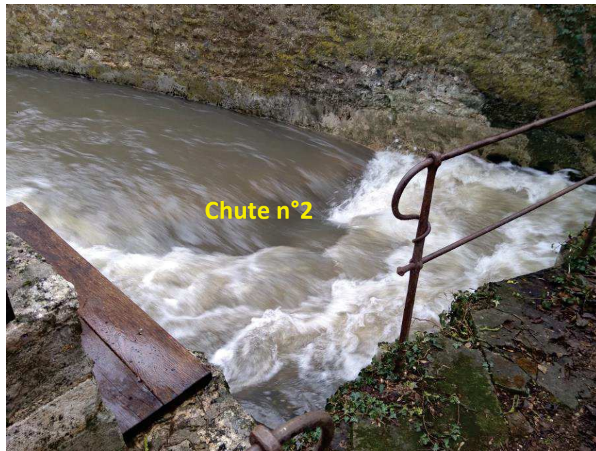
Chute n°2 - bras de décharge du déversoir - vannes fermées
