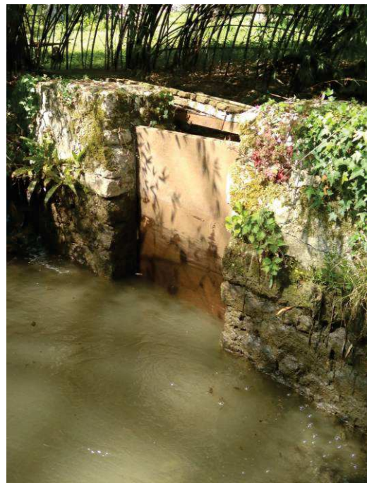
Prise d'eau O1 (à gauche) et exutoire de l'étang O2 (à droite)
