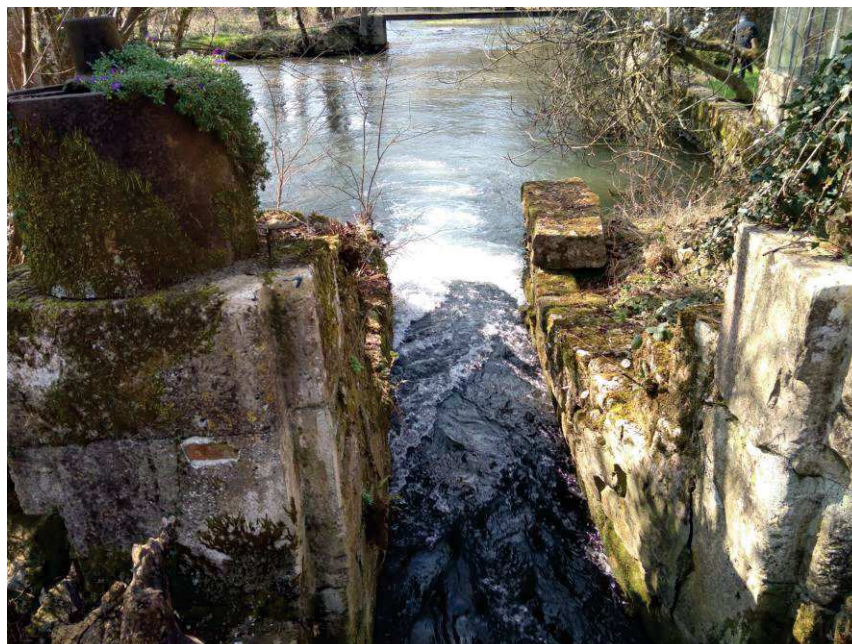
Ouvrage BOY1 - petit bras de décharge (partie usinière)
