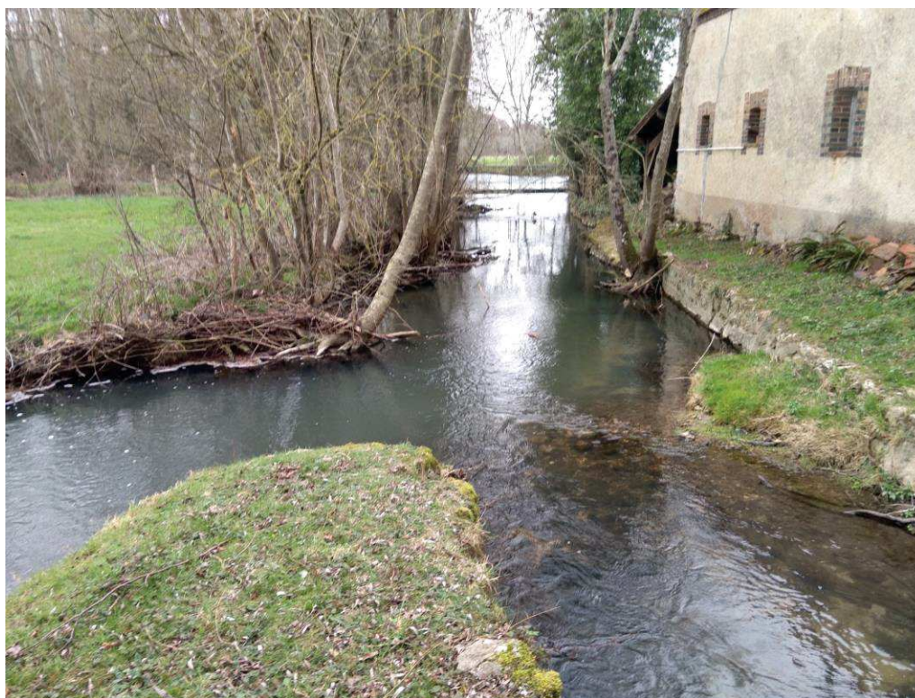
Vue sur aval de l'ouvrage CHAN2
