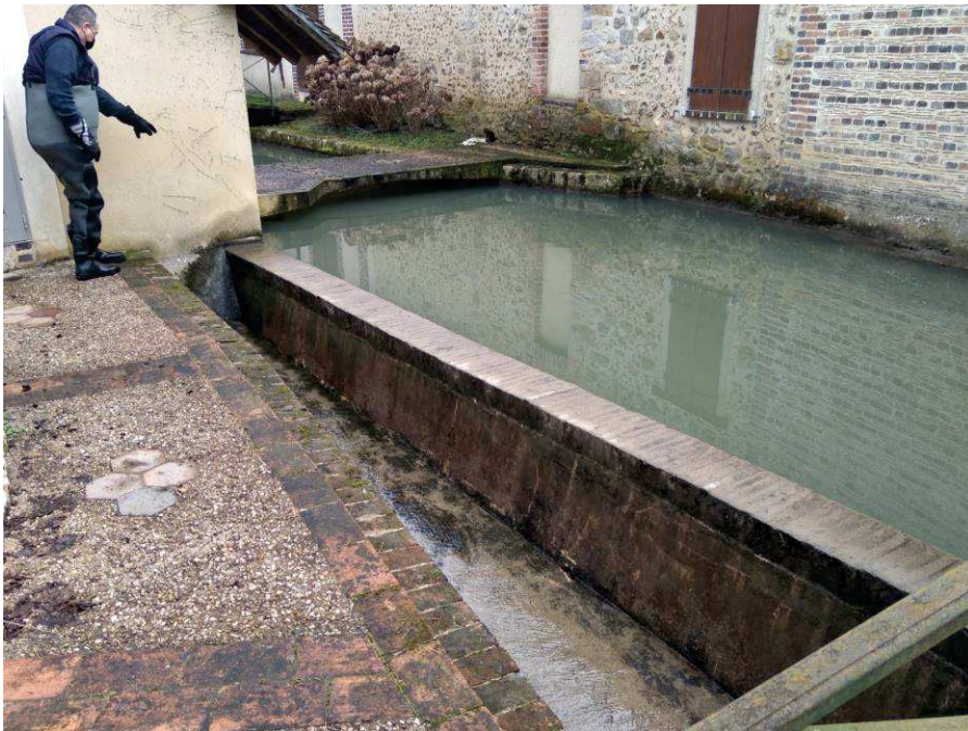
Déversoir du moulin du Vivier
