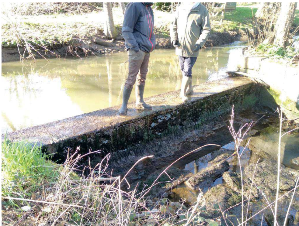
Déversoir FOU3 à sec - vannes ouvertes
