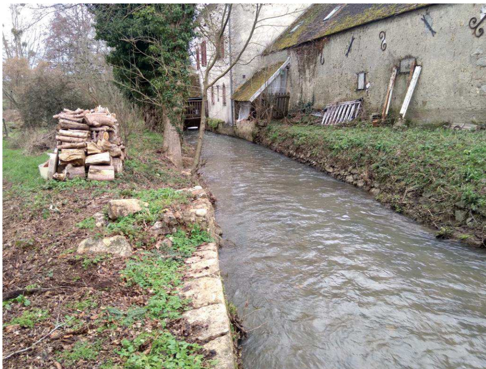
Vue sur le bief, entre BOI1 et BOI2
