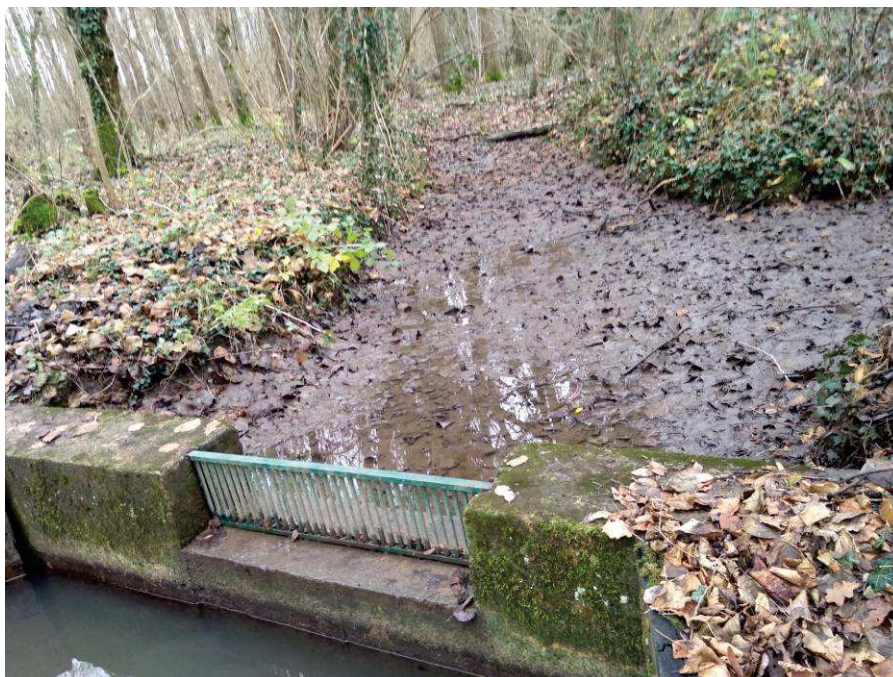
Vue sur l'ouvrage O1 - ancienne prise d'eau de l'étang
