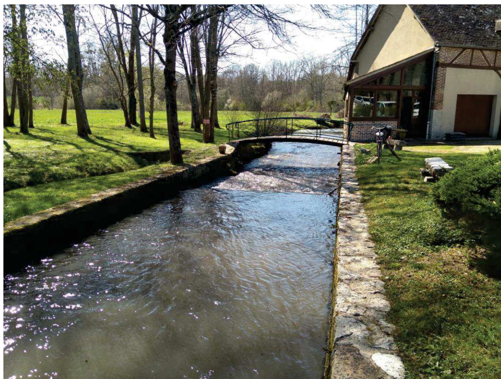
Bras de décharge - aval de HAI2
