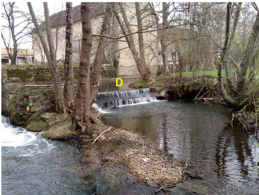
Ouvrage CHAN2 - déversoir D
