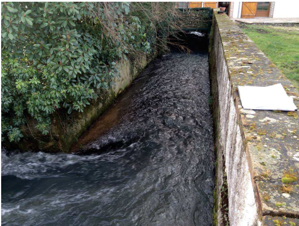
Coursier en aval de l'ouvrage FOR2
