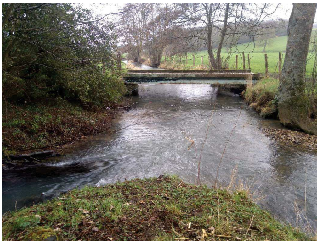
Confluence entre le bief et le bras en fond de vallée
