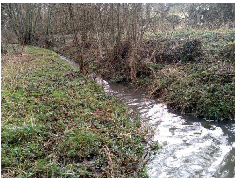
Exutoire de l'étang en aval immédiat du déversoir
