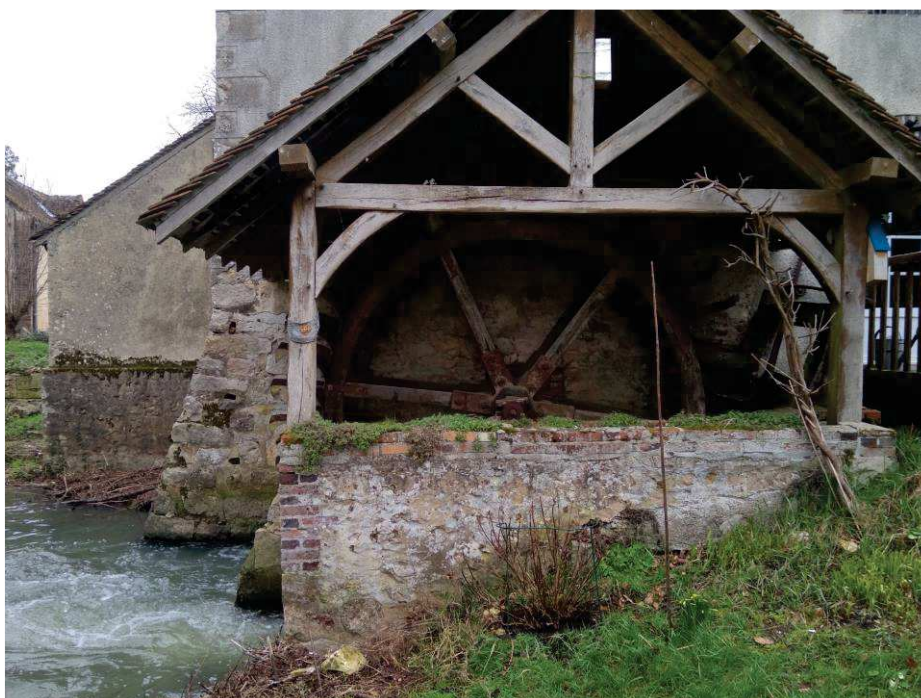
Ouvrage BOI1 : roue du moulin
