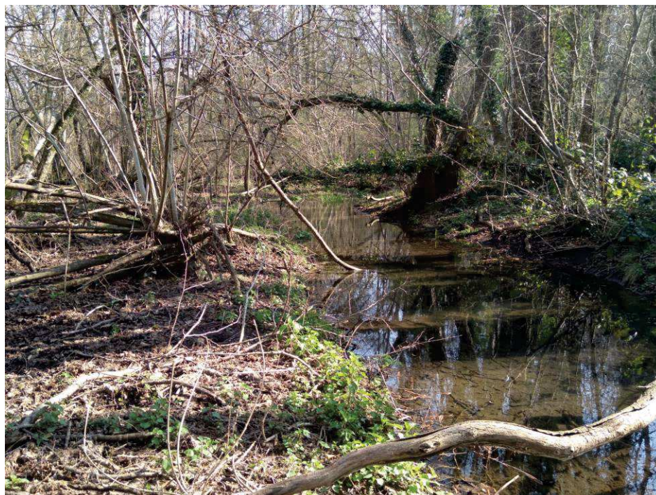
Annexe hydraulique située quelques mètres en amont rive gauche de l'ouvrage BOY2
