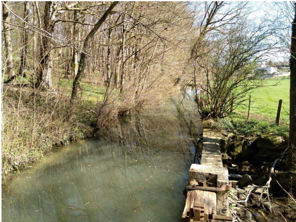
Vue sur le bief, amont immédiat de l'ouvrage LIF2- vannes fermées
