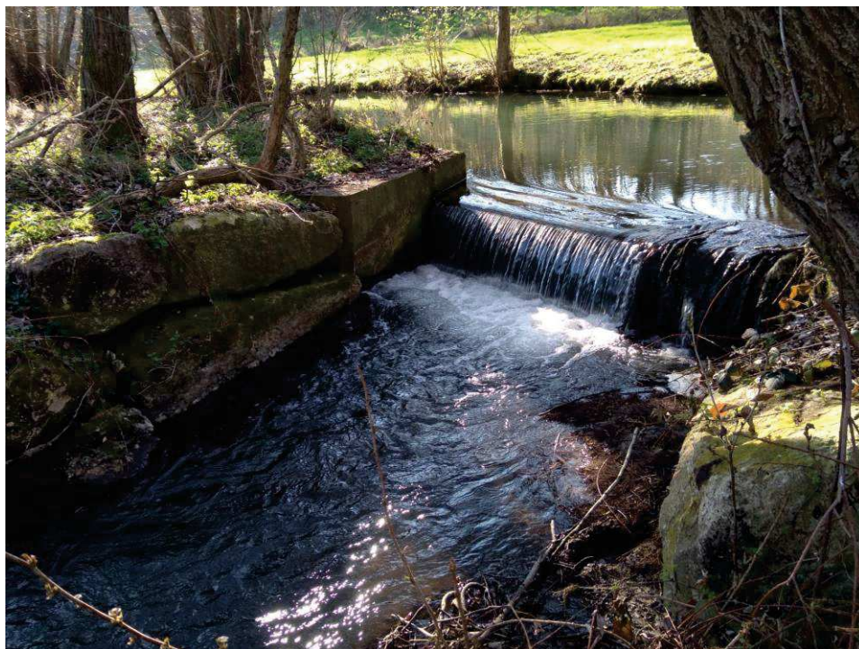
Ouvrage FOU3 - vannes fermées - déversoir construit dans les années 1990
