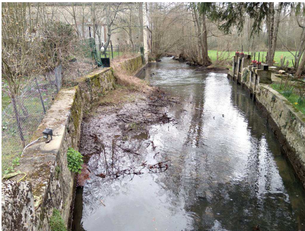
Vue sur l'amont du bief - vannes ouvertes
