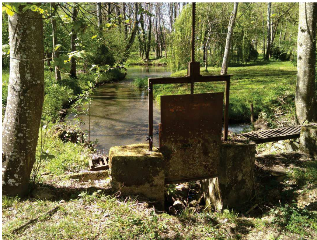
Ancienne ouvrage situé sur la berge rive gauche en aval du plan d'eau (n'a plus d'utilité à ce jour)
