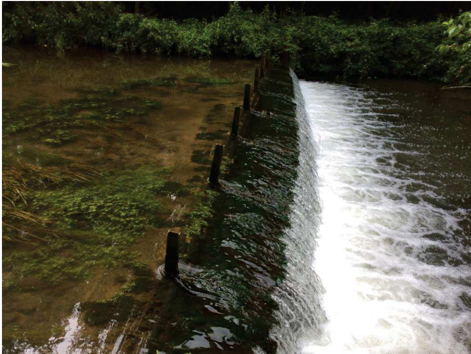
Déversoir (batardeau fermé)
