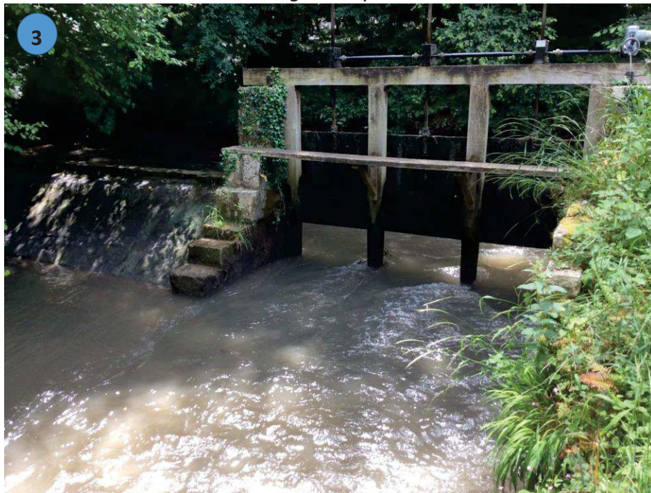
Vannes du déversoir ouvertes Ouvrage transparent
