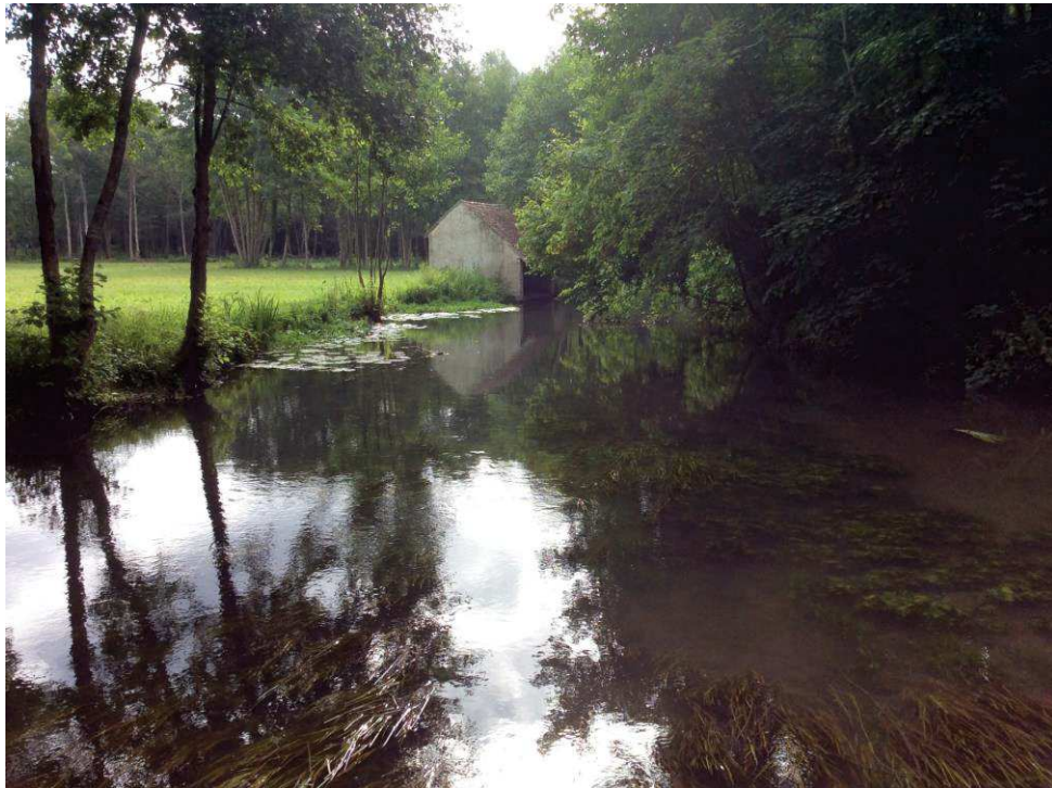
Vue en amont des ouvrages
