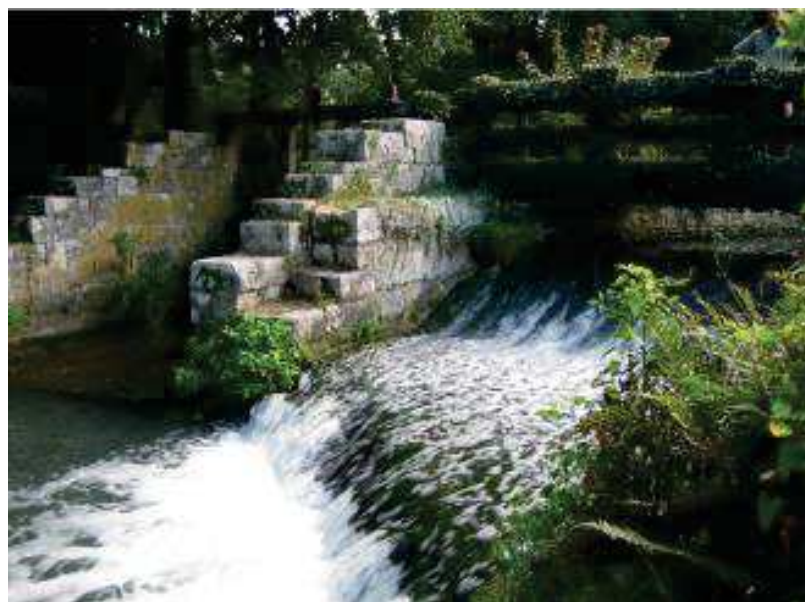
Vue sur le déversoir - bras n°2 (source : Géo-Hyd)
