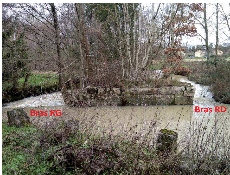
Vue sur les deux bras, présence des fondations des anciens ouvrages
