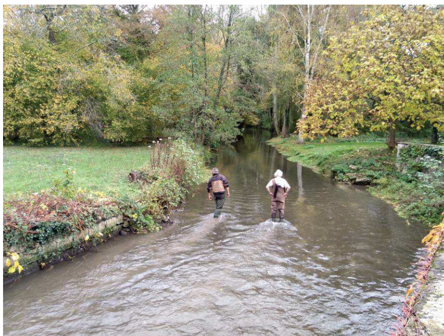
Vue en amont de l'ouvrage GRI1
