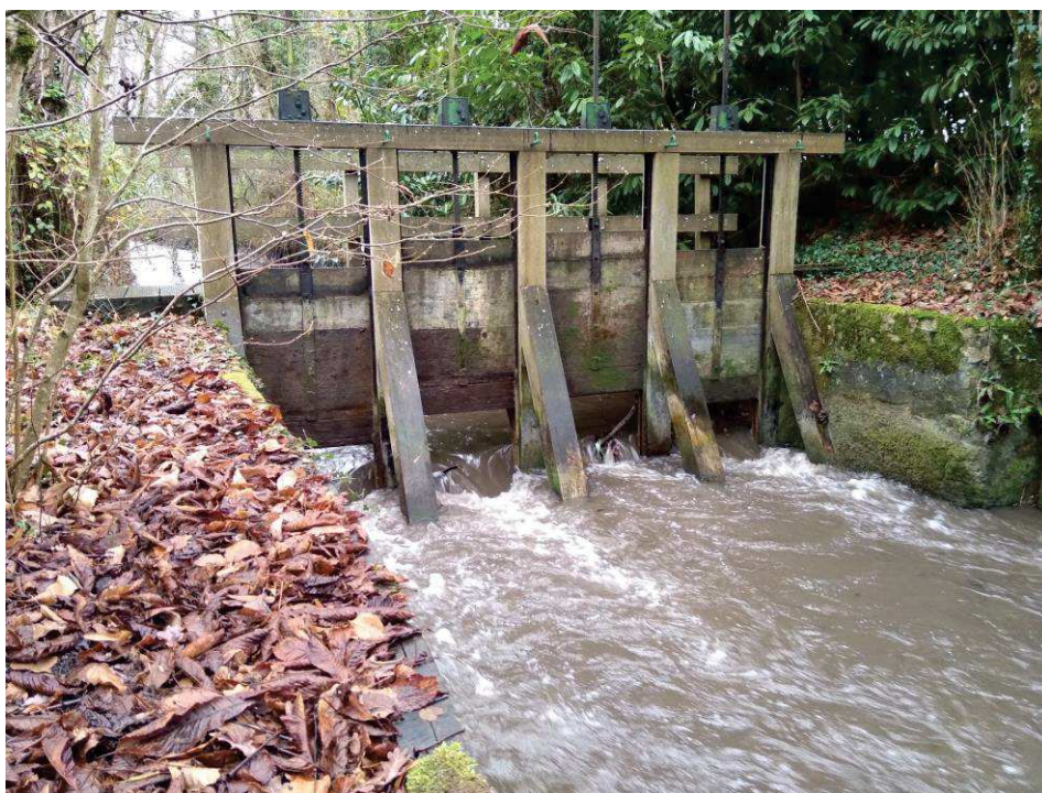
Vue sur l'ouvrage TAN1 au moment de l'ouverture des vannes
