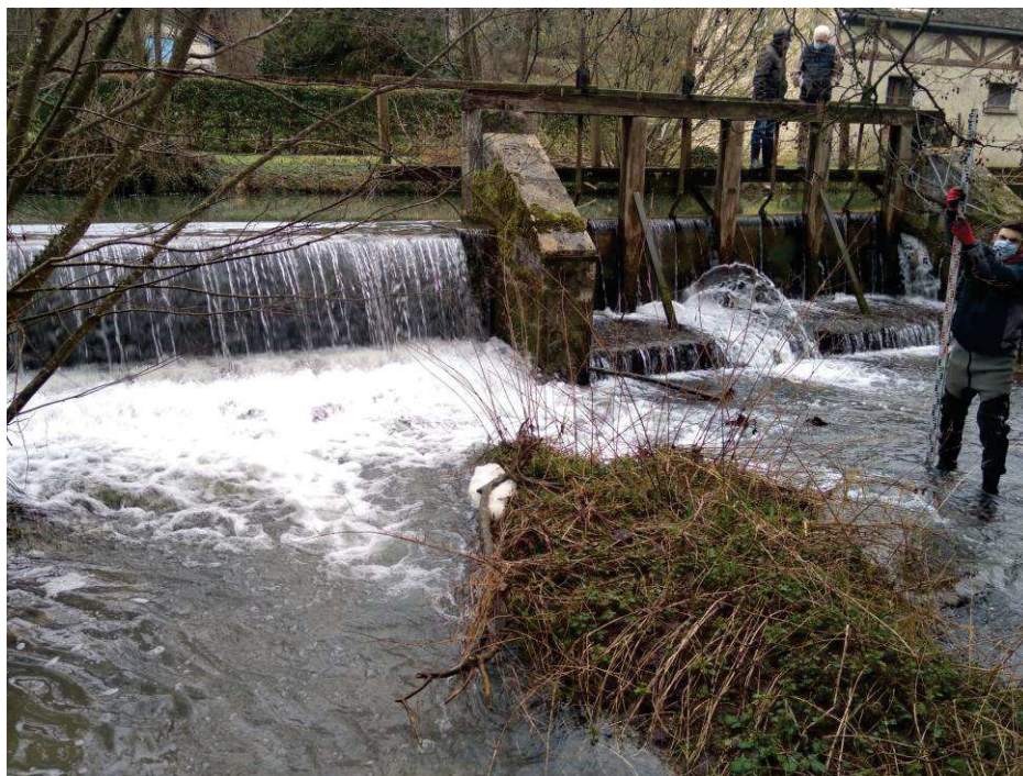
Ouvrage AUL2 : déversoir (à gauche) et 4 vannes (à droite)
