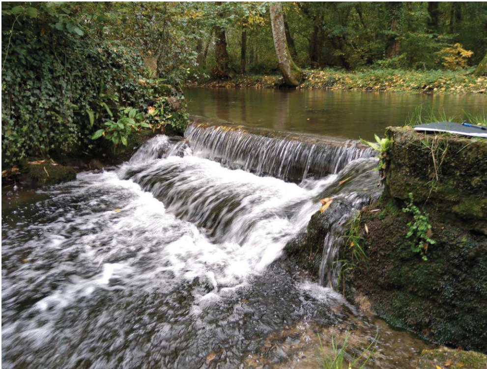
Vue sur le déversoir D2 (GRI2)
