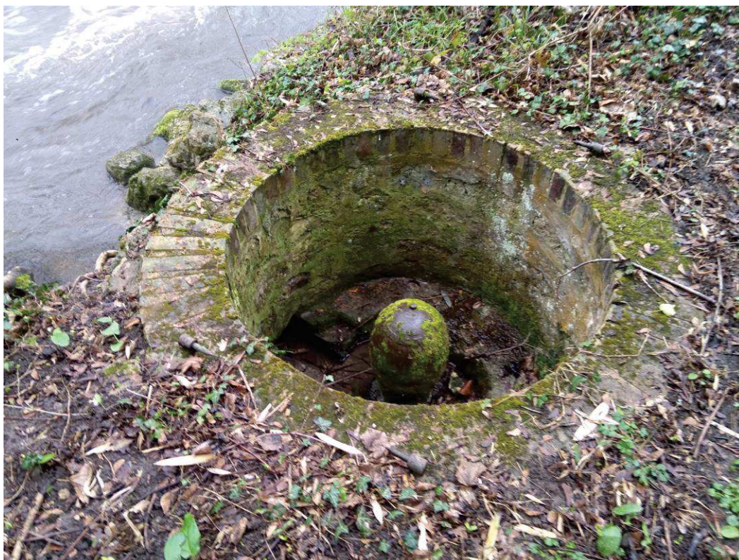
Ancienne turbine ? au droit de l'ouvrage PEC2, en rive droite
