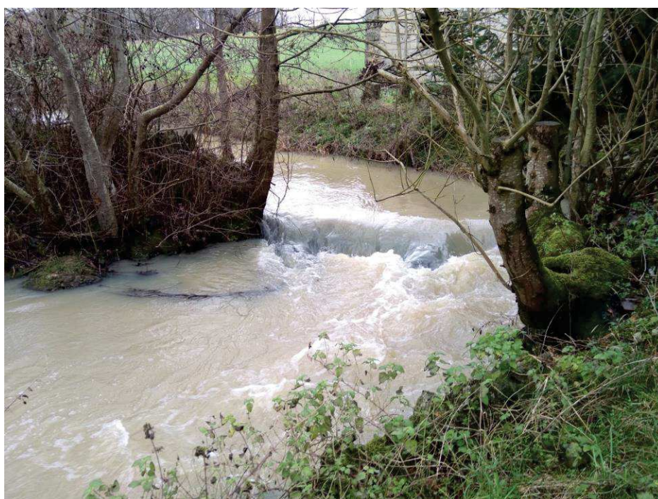
Reste de l'ancien ouvrage - bras RG
