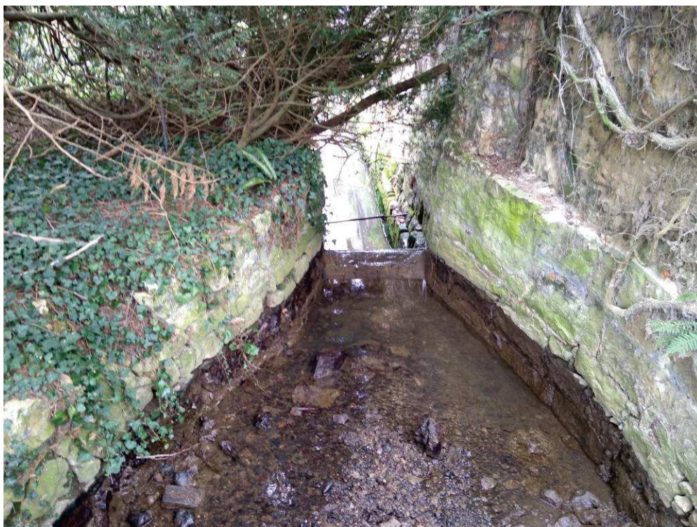
Ouvrage AND1 à sec (vannes ouvertes)
