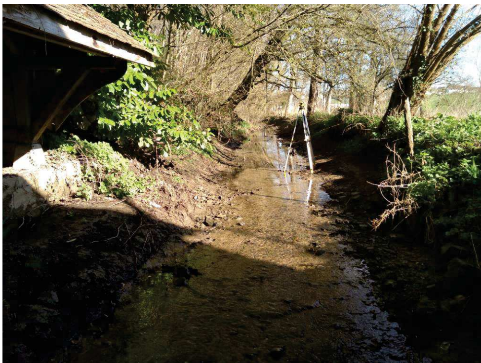
Vue sur le bief, amont immédiat de l'ouvrage LIF1 - vannes ouvertes
