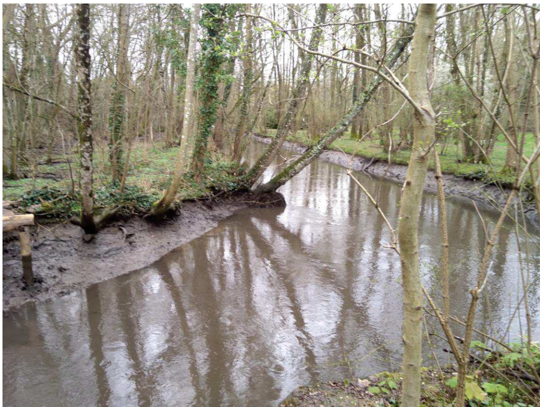
Vue en amont de l'ouvrage PEC2
