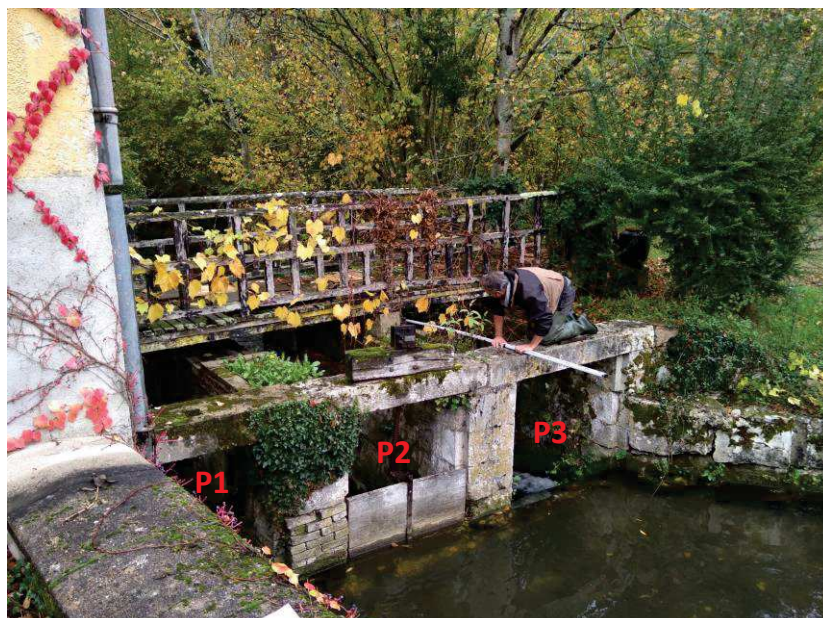
Vue sur l'ouvrage GRI1 avec les bras P1, P2 et P3
