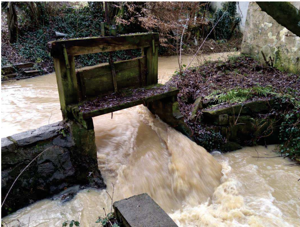
Vanne de décharge de l'ouvrage VIL2
