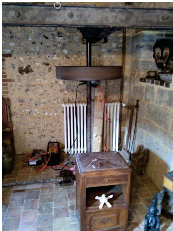
Turbine du moulin
