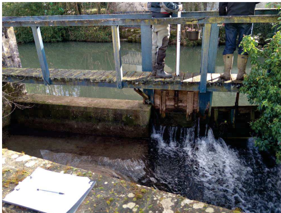
Ouvrage FOR2 - vannes fermées
