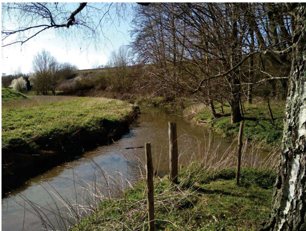
Confluence entre le bief et le bras de décharge
