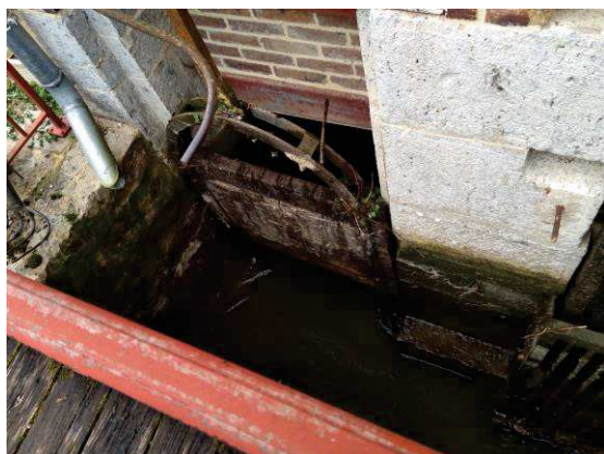
Ouvrage AUL1 : bras de décharge (à gauche) et bras usinier (à droite)
