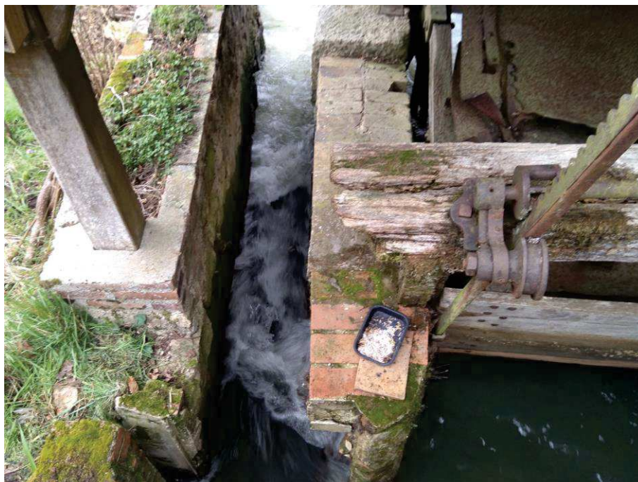
Ouvrage BOI1 : bras de décharge (à gauche) et bras usinier (à droite)
