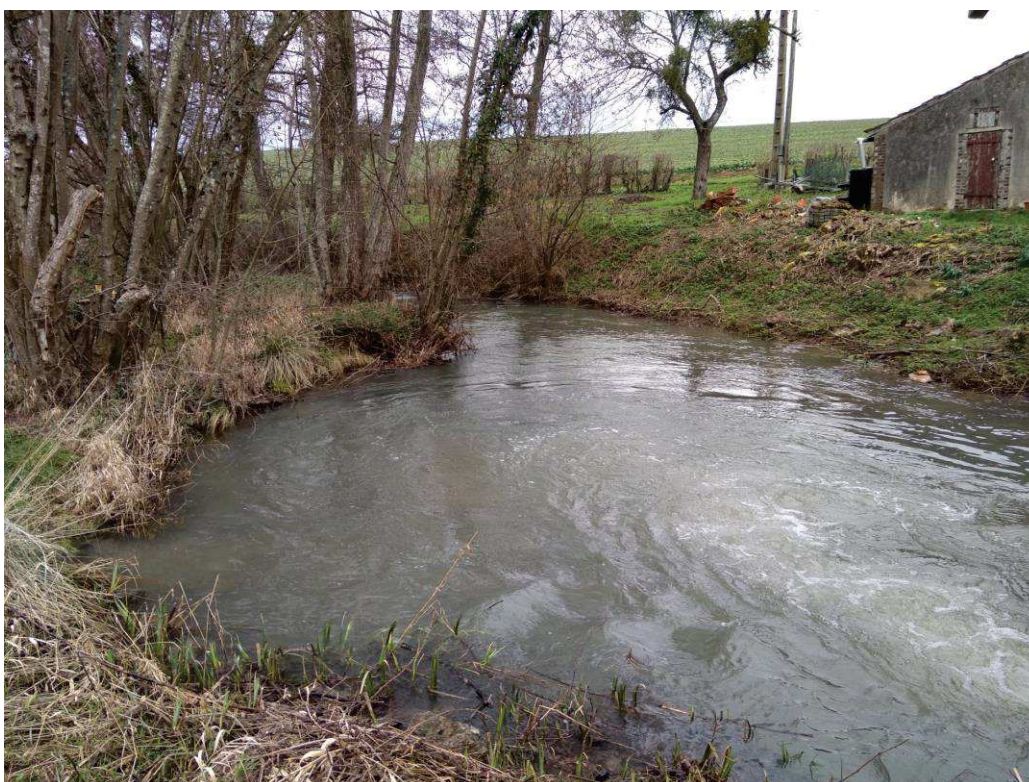
Aval de l'ouvrage BOI1, fosse de dissipation
