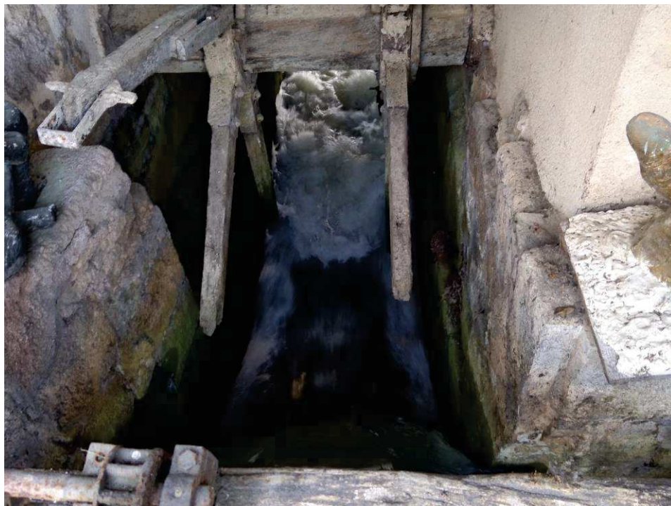
Ouvrage FOR1 - bras usinier (vanne non manoeuvrable)
