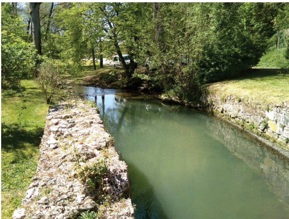
Vue sur l'aval de TOS1
