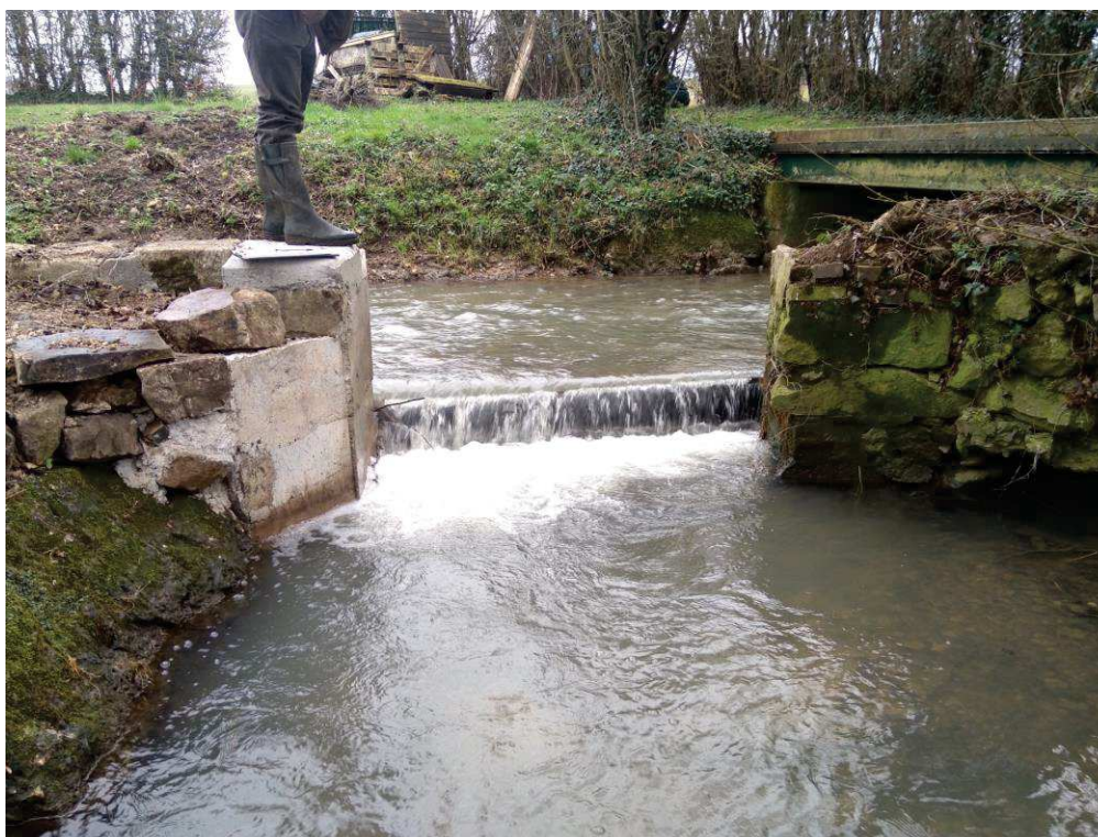
Ouvrage BOI2 : batardeau (planche) à l'emplacement des anciennes vannes. Présence de l'ancien déversoir à gauche de la photographie
